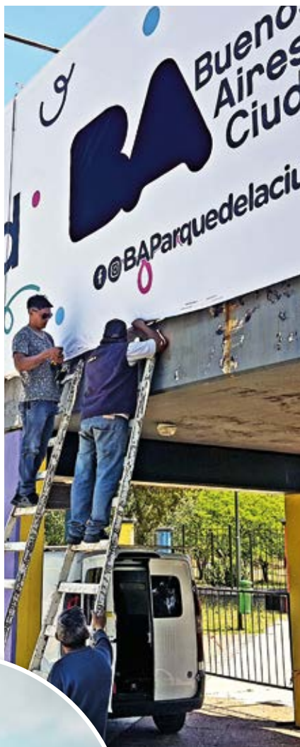
INSTALACIÓN EN ALTURA
